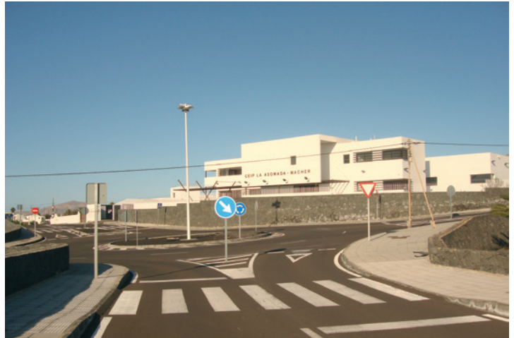
La Rotonda de La Asomada constituye un peligro para la integridad de nuestros hijos.
