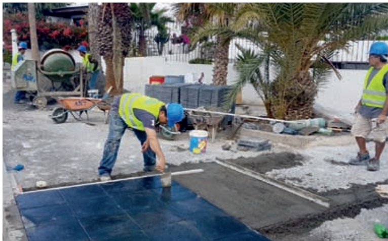
Mejoras del acerado en el municipio de Tías. Calle Roque del este.
