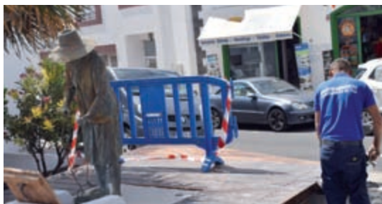
Mantenimiento de vías y obras.
