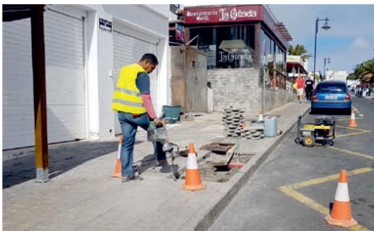
Mejoras del acerado en el municipio de Tías. Calle César Manrique.
