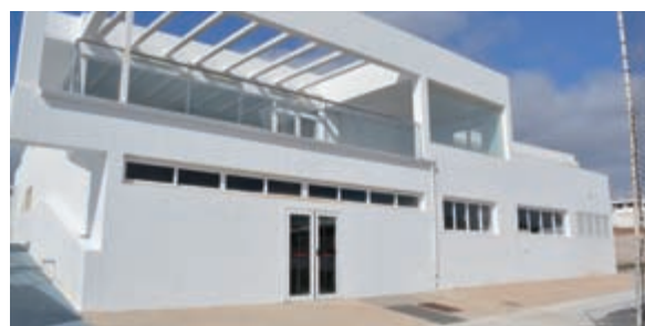
Nueva cafetería y sala en Polideportivo municipal
