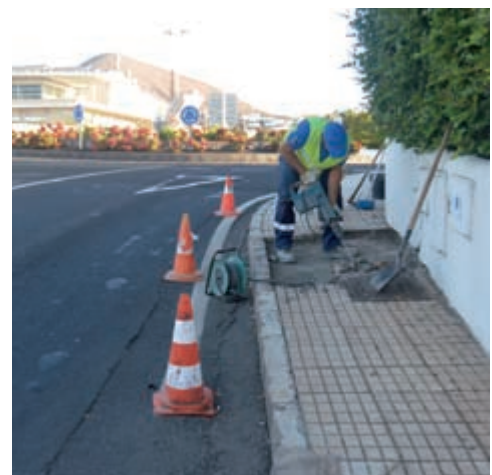
Acondicionamiento de aceras.
